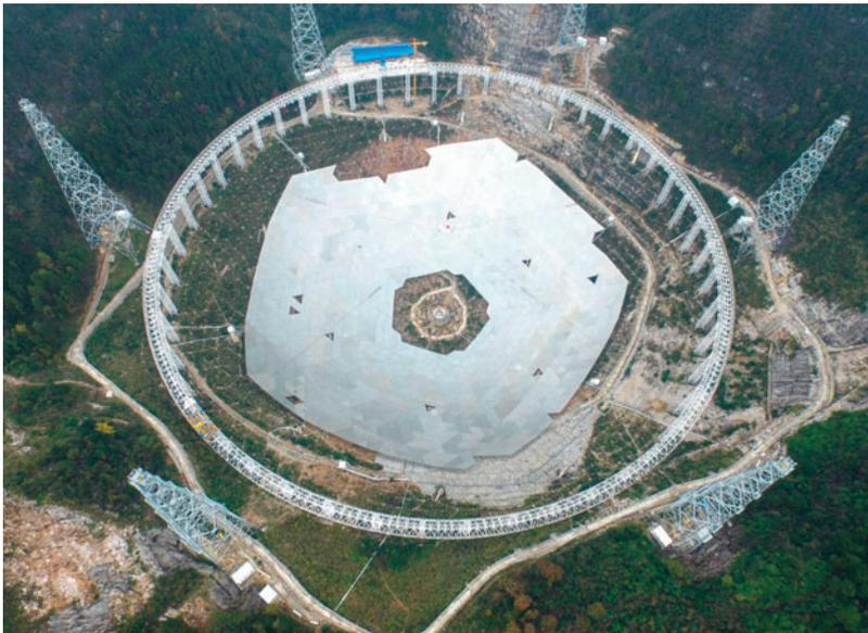
complessivi 4450 tasselli di alluminio, quasi tutti triangolari e leggermente curvi, con lati di 11 metri (177 elementi hanno invece forme diverse). Tutti i tasselli sono fissati su una rete composta da migliaia di funi di acciaio agganciate fra loro da robusti morsetti, e il perimetro dell'intera struttura è fissato a un colossale traliccio circolare, lun-
